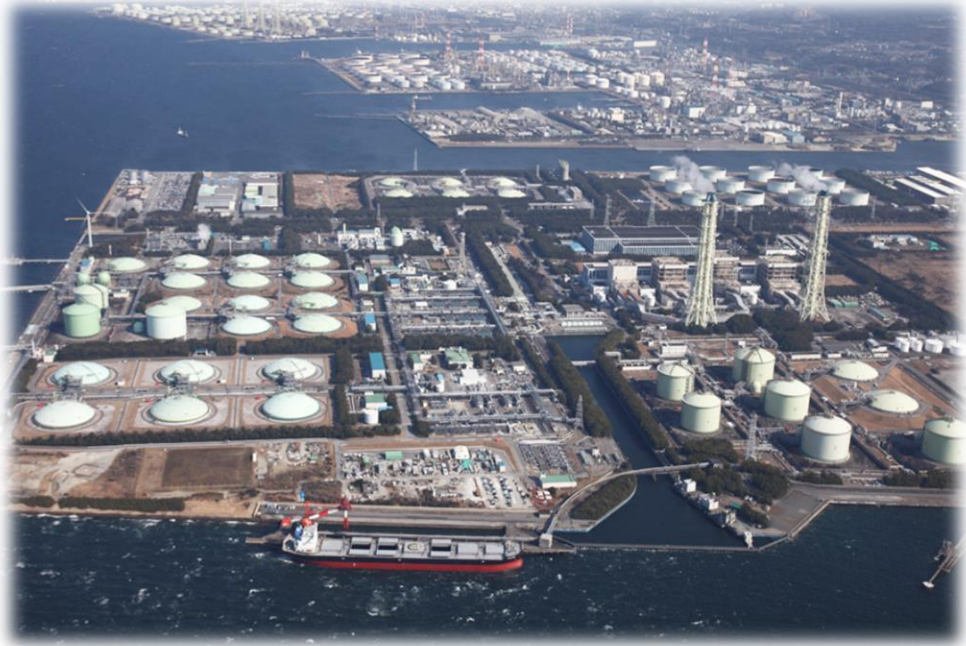
Sodegaura Thermal Power Plant & LNG Terminal
