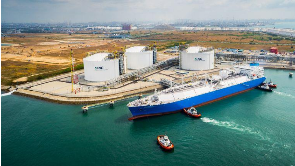
Singapore LNG terminal– 11 mtpa
