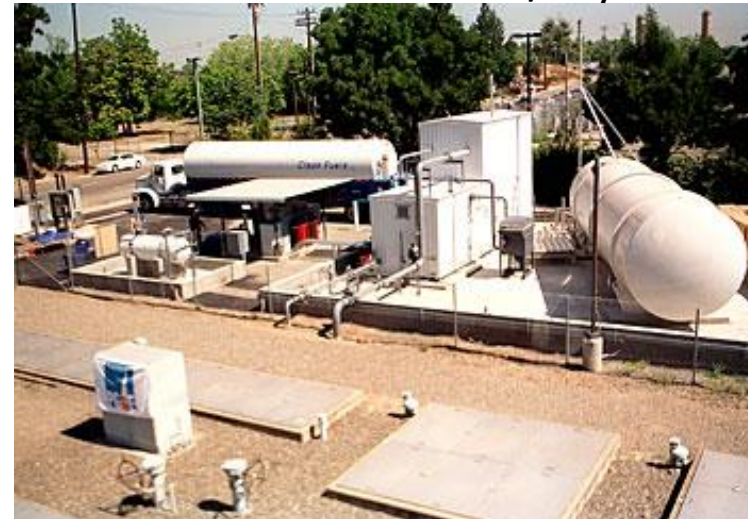
10 tonnes per day
